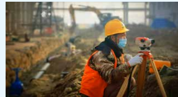
工程测绘 拍摄：李强
