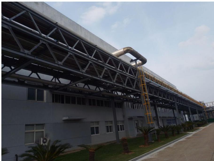
图 4.5-1 厂区架空管廊设置
