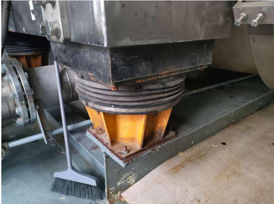
图4.3-1 噪声污染防治措施示意图片（减震装置）
